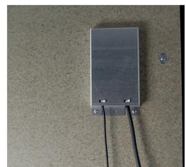
16. Hängen Sie das Abdeckblech in die Öffnung ein und zeichnen die Befestigungslöcher an.
